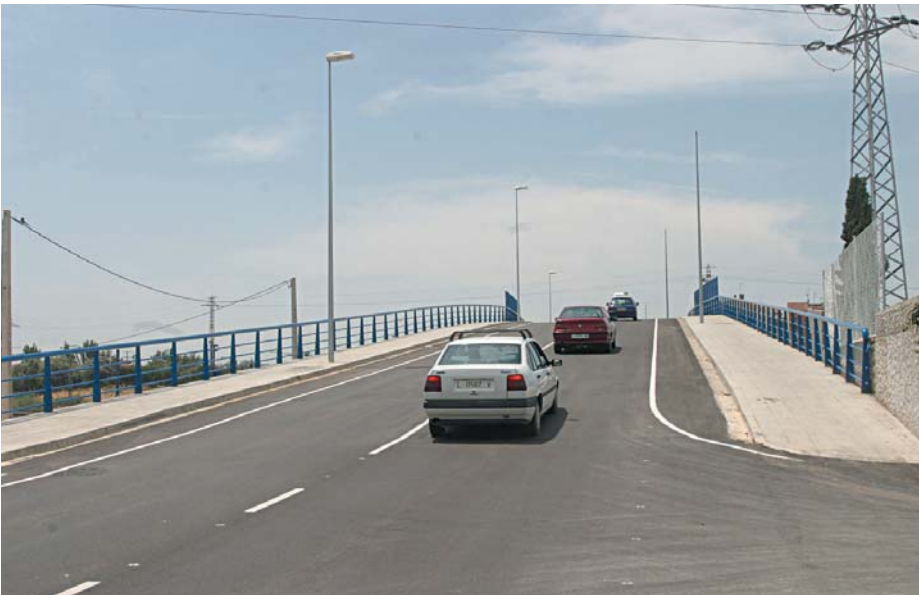
El viaducte permetrà el pas de l'AVE ahora que facilita l'enllaç entre la Bordeta i els Magraners.
