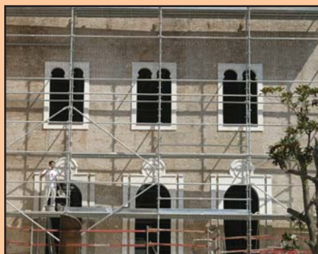
Rehabilitació de la façana exterior.
