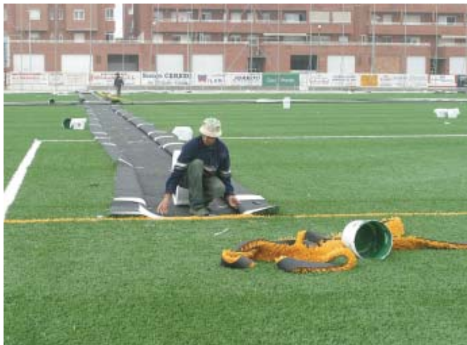
Instal·lació de gespa artificial al camp de la Bordeta, apta per a competicions de futbol 7 i 11.
