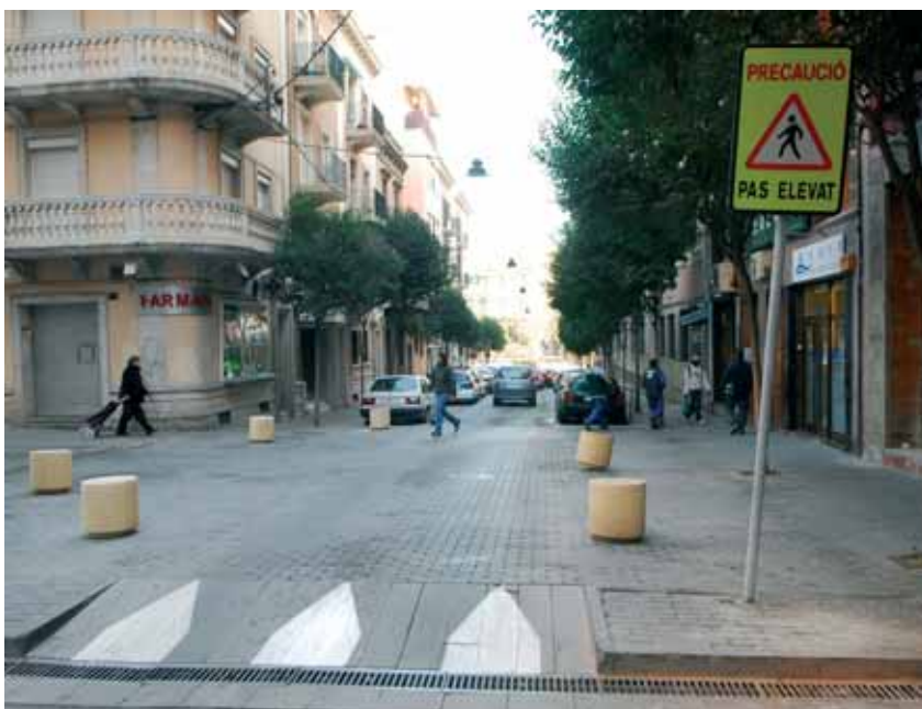
L'elevació dels passos de vianants fa més còmode i segur el creuament del carrer per part dels ciutadans.
