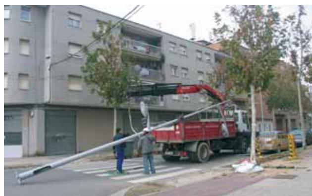
El reforç de l'enllumenat inclou la instal·lació de 30 noves columnes de llum.
