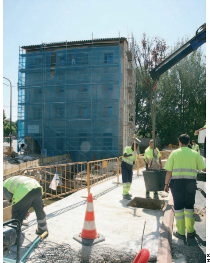
S'ha instal·lat arbrat, mobiliari urbà, fanals i una vorera a Impressor Botel.
