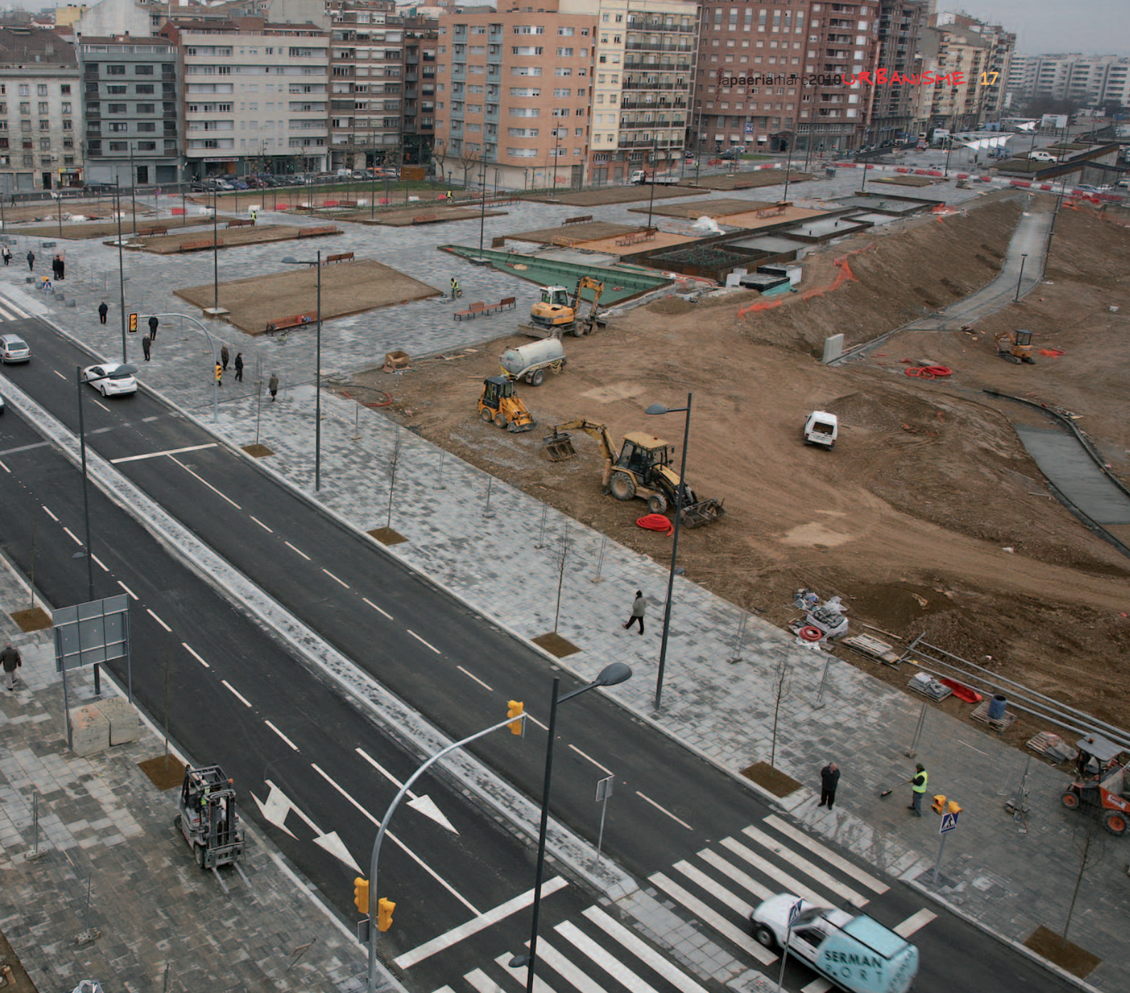
AUTORITATS EN L'ACTE D'OBERTURA (PÀG. ANTERIOR) I PRIMERS VEHICLES QUE VAN ESTRENAR EL PONT DE PRAT DE LA RIBA. © H. SIRVENT
