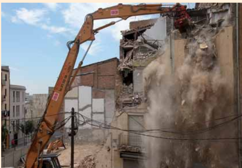
ENDERROC D'EDIFICIS PREVI A LA CONSTRUCCIÓ DE L'APARCAMENT AL CARRER CAVALLERS. © H.S.
