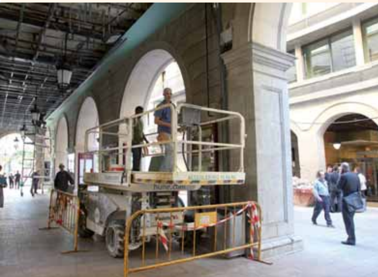
OBRES DE REHABILITACIÓ DE LES "PERXES" DE LA PLAÇA PAERIA. © H. S.
