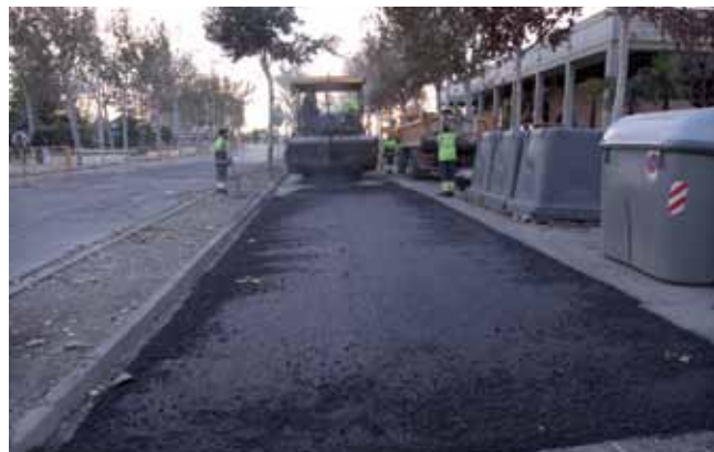
Tasques de reparació del ferm de l'avinguda Onze de Setembre. © H.S.
