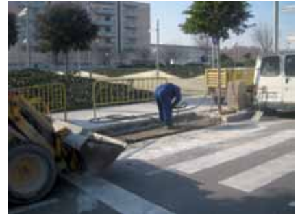
Nou pas elevat al carrer Euskadi. © Urbanisme
