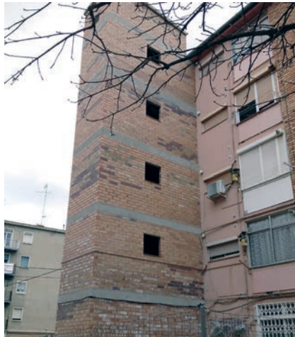
Obres per instal·lar un ascensor. © Paeria
