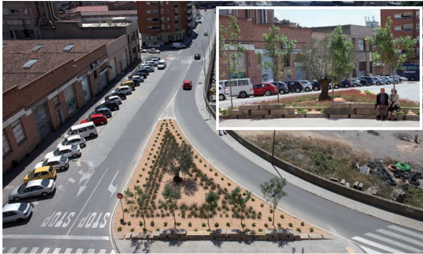
Aspecte de les obres de millora del tram de Roger de Llúria amb Comtes d'Urgell. © Urbanisme
