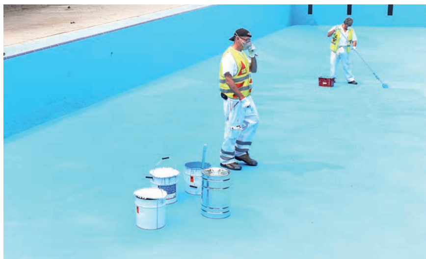
Els operaris municipals han pintat tota la piscina de Gardeny. © H. Sirvent
