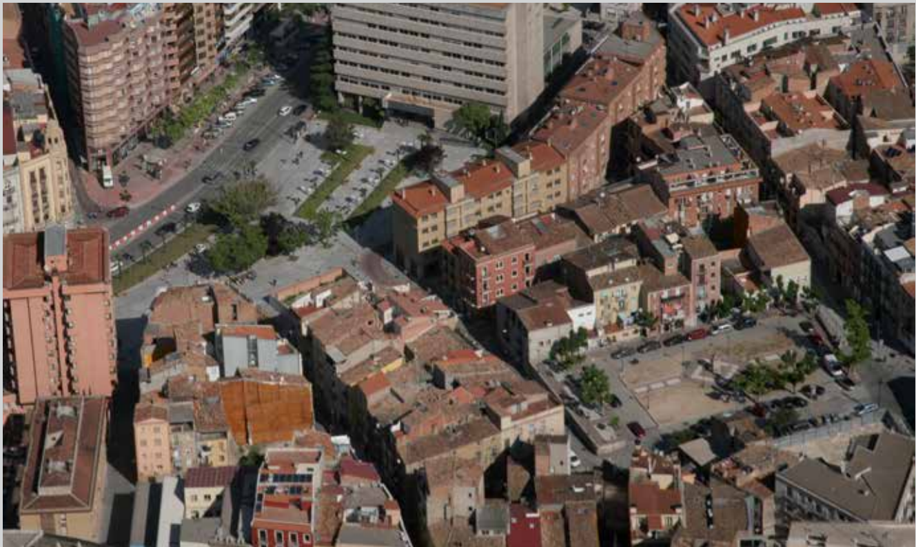
Vista aèria del Centre Històric, on l'Ajuntament ha invertit més de 29 milions d'euros en la construcció d'habitatges socials. H. Sirvent
