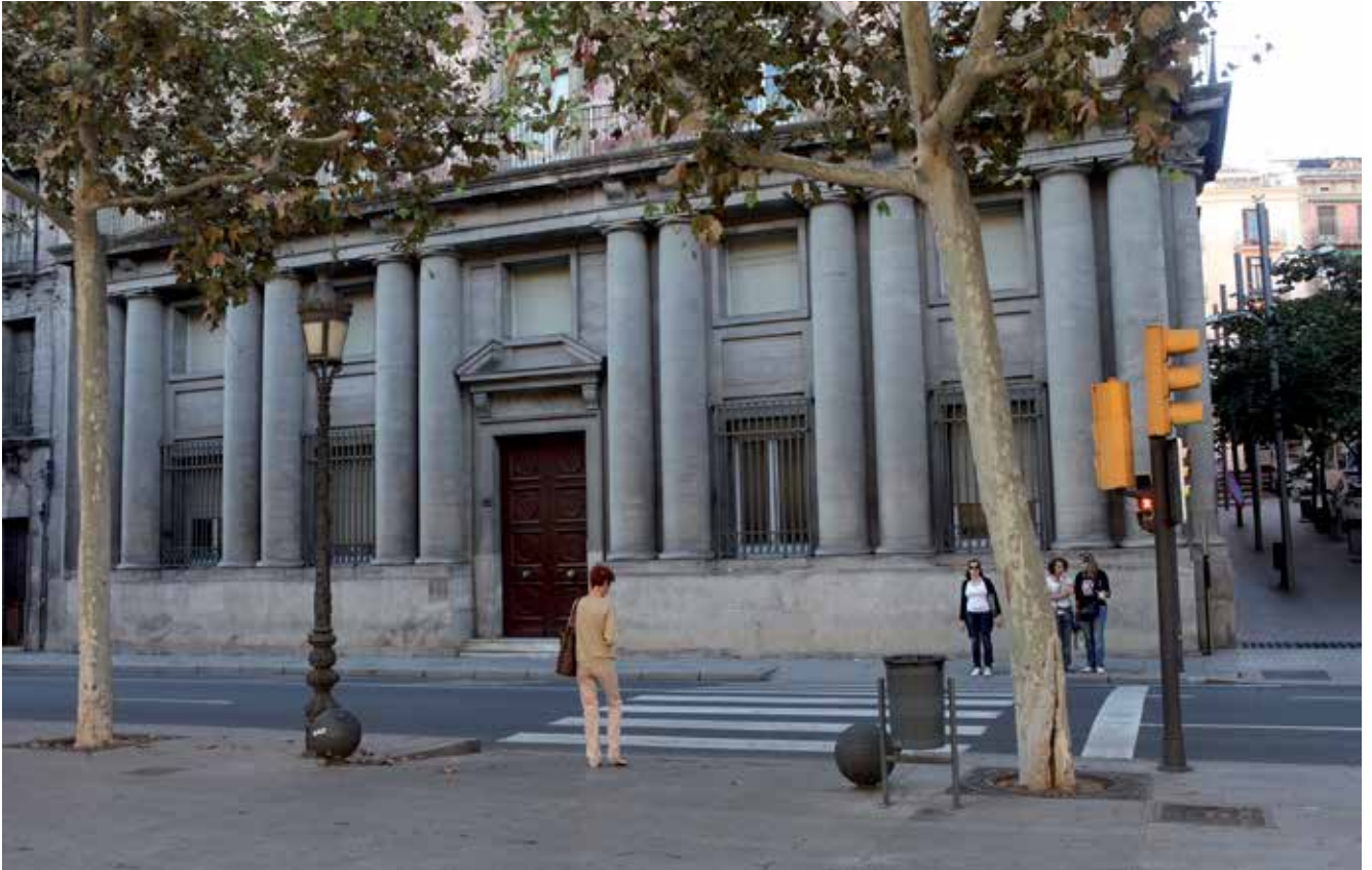
L'edifici de l'antiga Audiència té gairebé 4.000 metres quadrats i consta de cinc plantes. © H. Sirvent
