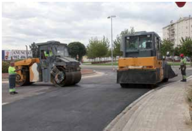
Tasques d'asfaltatge a l'altura del carrer Laureà Figuerola. © H. Sirvent
