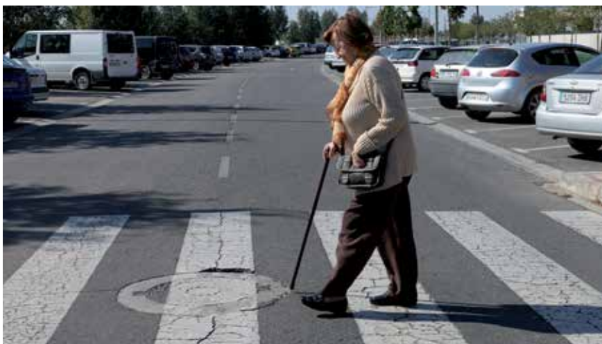
Es donen consells i es posen exemples pràctics per anticipar-se a situacions de perill. © H.S.
