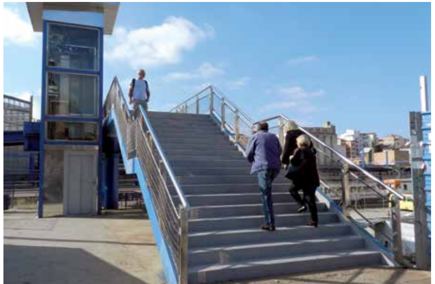
Escales de la passarel·la de la part del carrer Roger de Llúria. © Serveis de Comunicació
