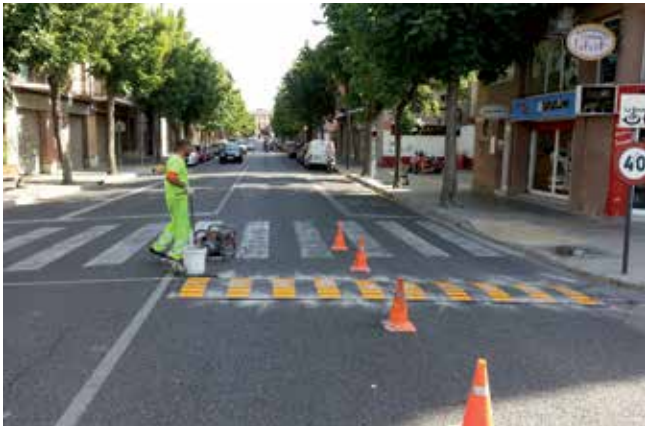
Instal·lació de bandes reductores a l'avinguda de les Garrigues. © H. S.
