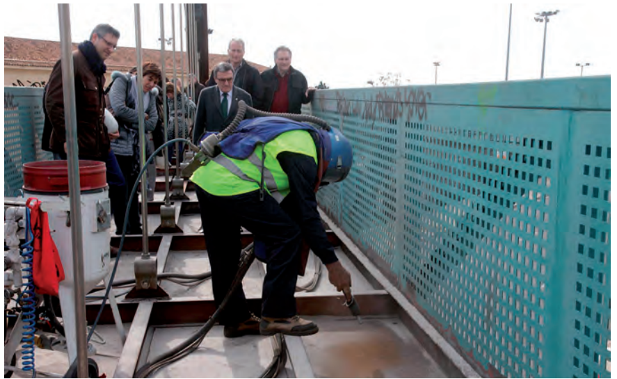
Les obres volen eliminar els problemes d'oxidació de la passarel·la. © H. Sirvent
