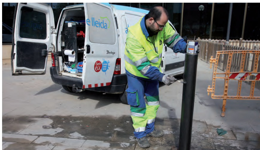
També es fa neteja, repassada i pintada del mobiliari urbà. © H. Sirvent
