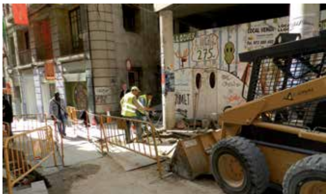
Treballs d'ampliació de les voreres al carrer la Palma. © H. Sirvent
