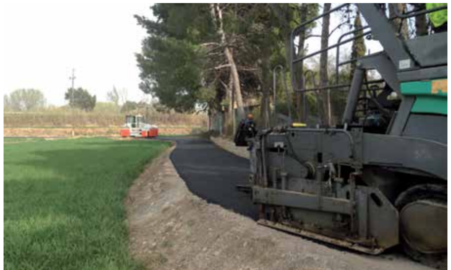
Les obres han permès instal·lar noves canonades de polietilè. © H. Sirvent
