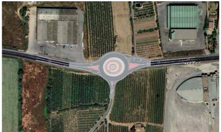
La rotonda de Butsènit tindrà un diàmetre exterior de 39 metres. © H. Sirvent
