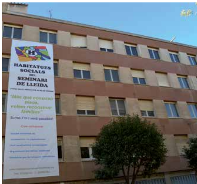
Es faran 19 habitatges de 50 i 70 m 2 . © Hermínia Sirvent
