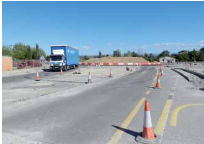
Obres a la rotonda situada a la intersecció de la Caparrella. © S. C.
