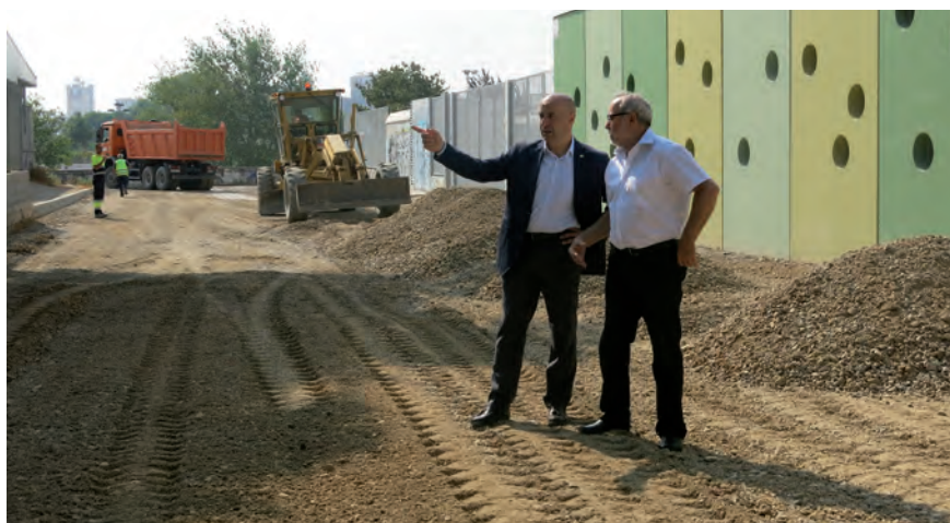
Les obres han permès arranjar tot el camí. © H. S.
