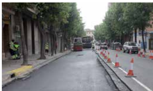
Treballs de repavimentació de la calçada. © H. S.
