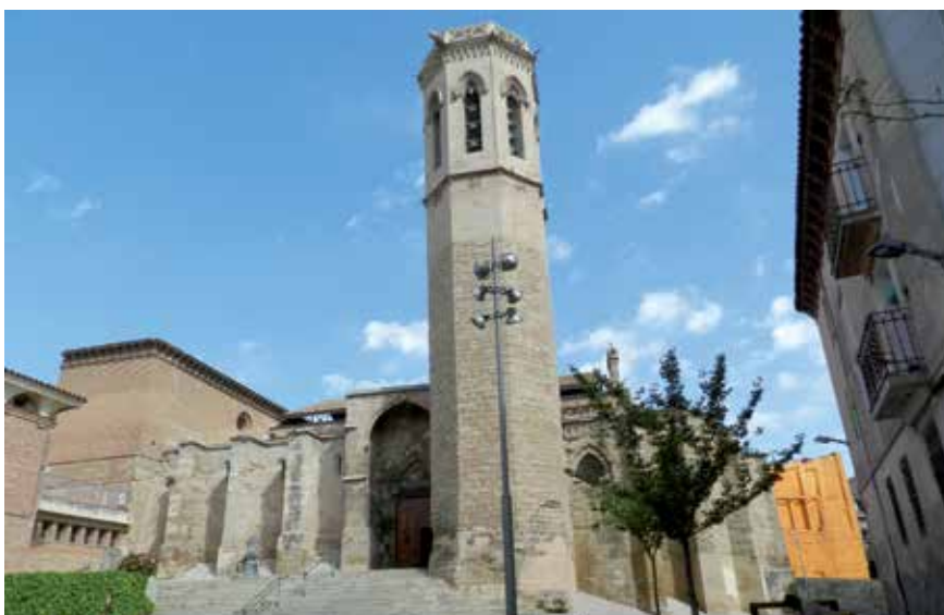
La millora inclourà tot el sistema d'enllumenat, des dels projectors als cables. © S. Comunicació
