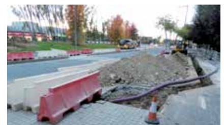
Obres a l'avinguda Rovira Roure. © S. C.
