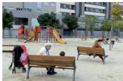
Nou paviment amortidor amb sorra. © S. C.
