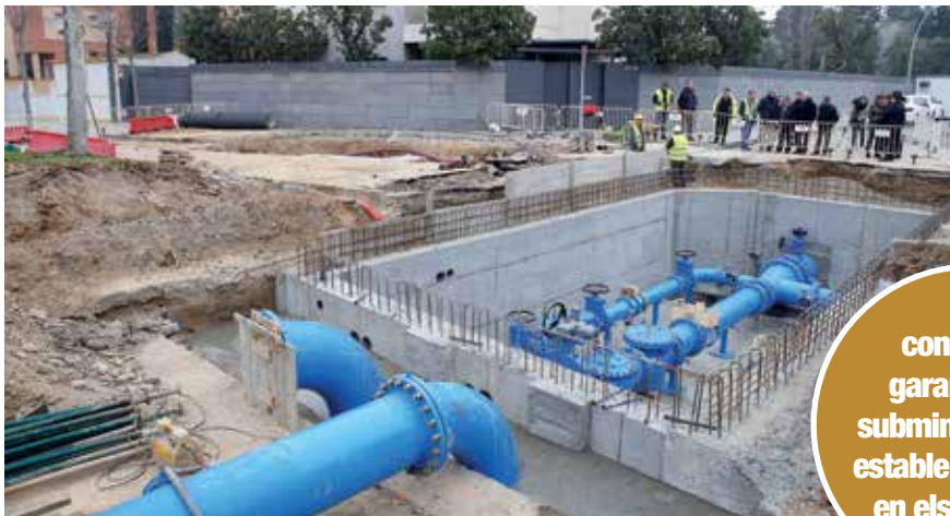
Connexió de la nova canonada d'aigua procedent de Pinyana. © H. S.
