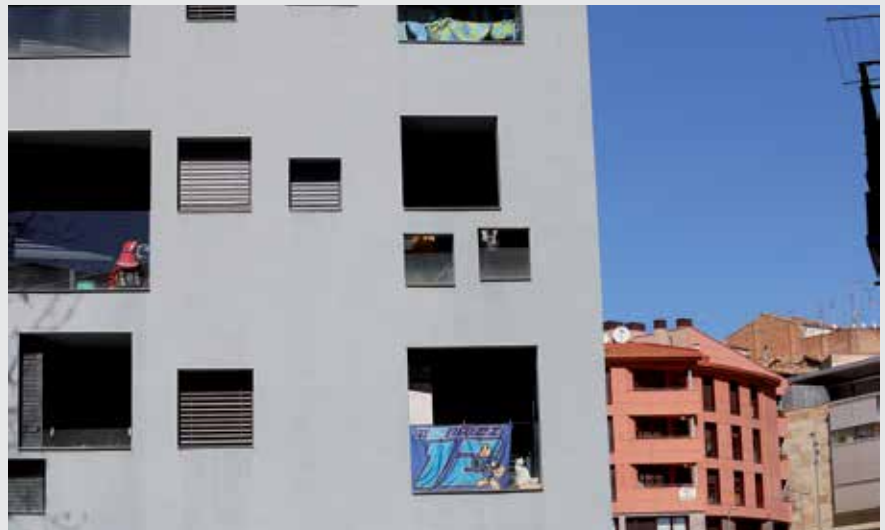
Detall dels pisos socials habitatges al carrer Lluís Besa, 6-8. © Herminia Sirvent
