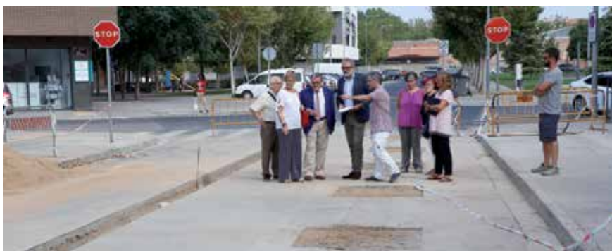
Les autoritats visiten les obres que es fan al voltant del centre Francesco Tonucci. © H. S.
