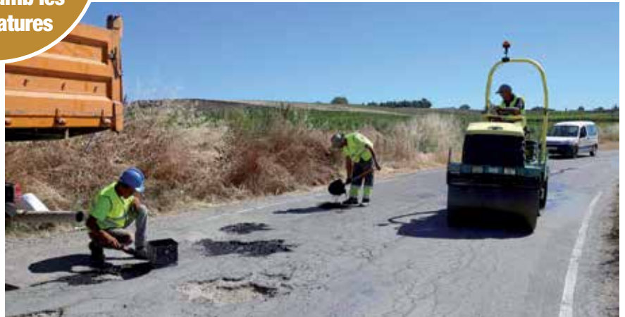
Actuació d'arranjament del ferm del Camí de Torres de Sanui feta a l'estiu. © H. Sirvent
