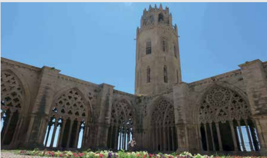
La remodelació del claustre, una de les darreres intervencions fetes al monument. © Paeria
