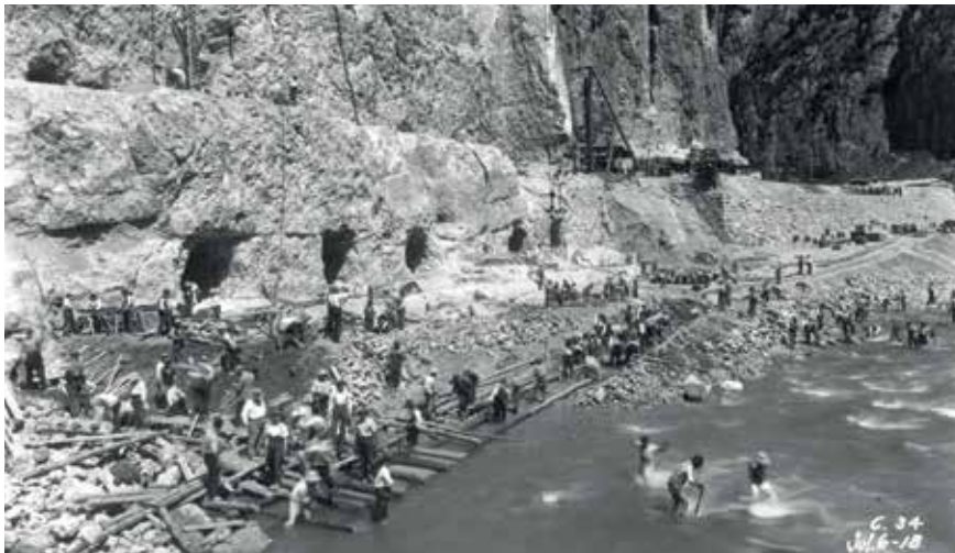
Obres de la central hidroelèctrica de Camarasa (1917). © Arxiu del Museu de l'Aigua
