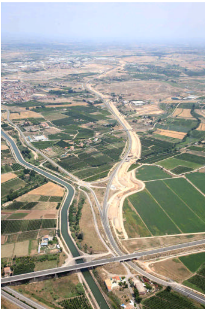
Vista general de l'obra
