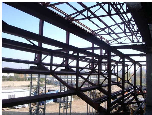
Vista interior voladís eix 19 (Costat pont).
