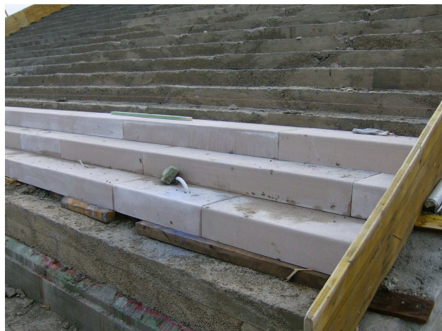
Col·locació revestiment grades Mercolleida
