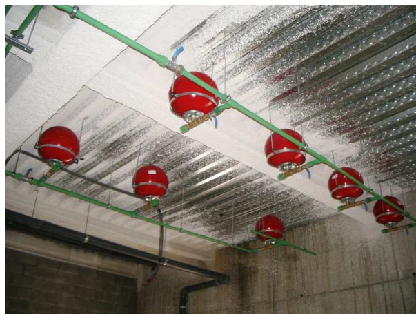
Vista sostre banys planta primera T.05.038-039.
