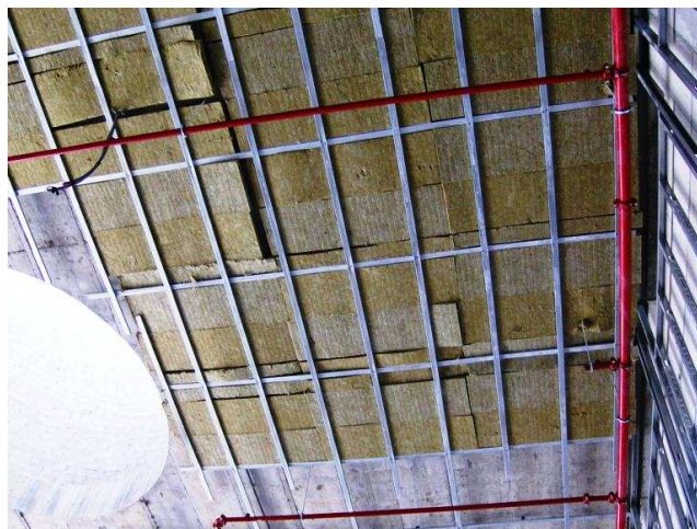
Aïllament acústic sala multifuncional
