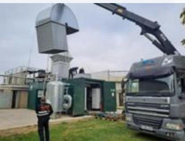
Instal·lació sistema filtració / refrigeració cogeneració 360 kW
