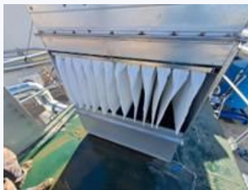
Instal·lació sistema filtració / refrigeració cogeneració 360 kW
