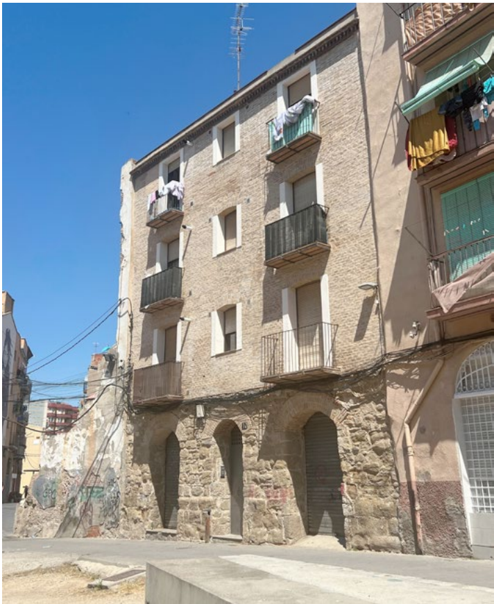
Rehabilitació de tres habitatges de l'edifici situat al carrer Galera número 10
