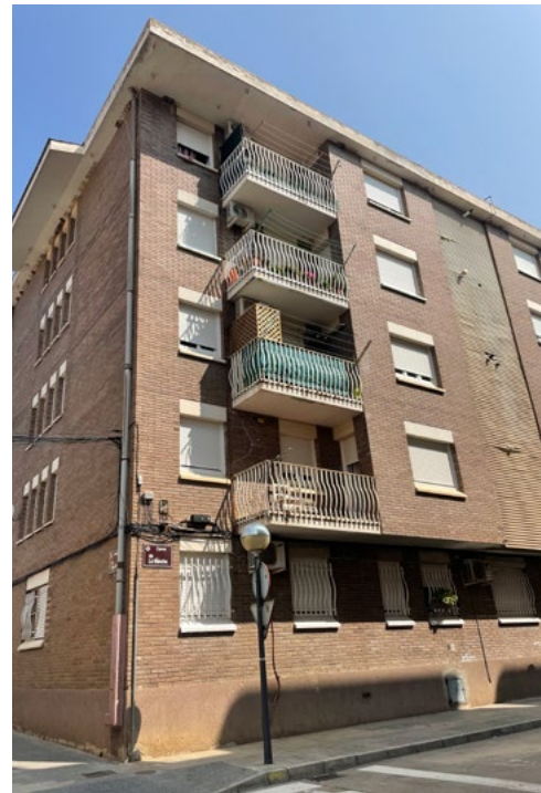
Rehabilitació de 50 habitatges al carrer Cuenca.
