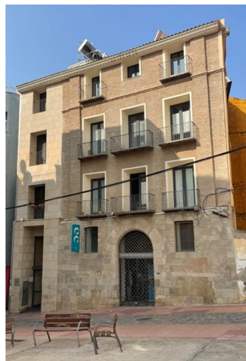
Rehabilitació d'uns tallers al carrer Cavallers, 31-33.
